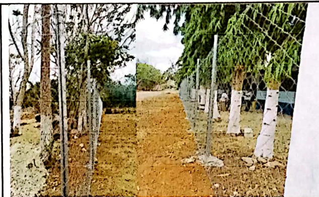
Renglon No. 5: Fotos del proyecto de sustitucion del cerco de madera por malla metalica y tubos de metal y alambre espigado, ya finalizado.
