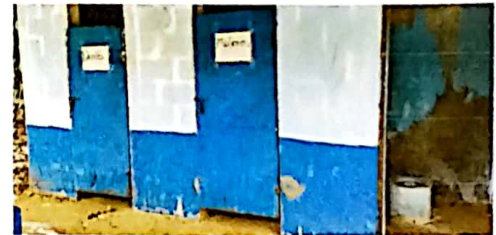
Foto 4: Estas son las puertas de los baños.
