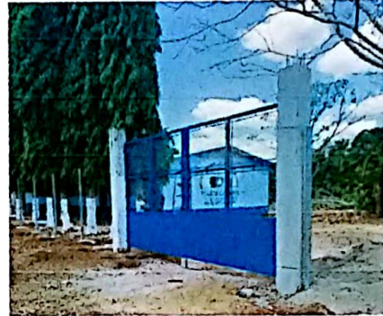
Renglon No. 2 . Foto del proyecto del portón ya finalizado.
