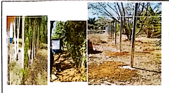
Reglon No. 5: Fotos de antes, durante del proyecto de sustitucion del cerco de madera por malla metalica y tubos de metal y alambre espigado.
