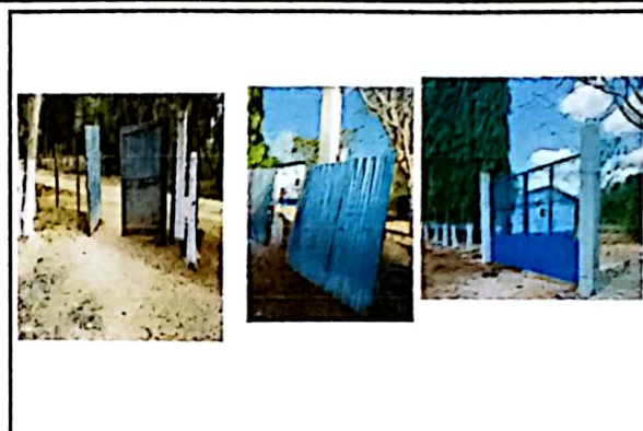
Renglon No. 2. Fotos antes y durante del proyecto de sustición del porton de lamina por metal.
