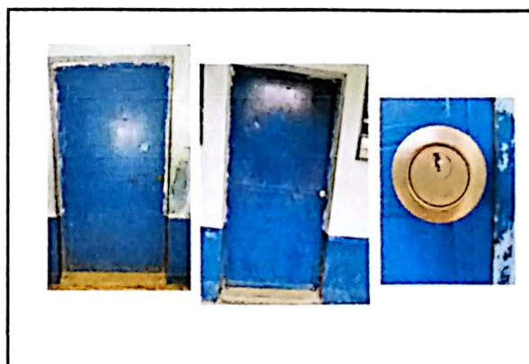
Renglon No. 4: Fotos de antes y durante del proyecto de sustitucion de chapas de las puertas de las aulas y la bodega.
