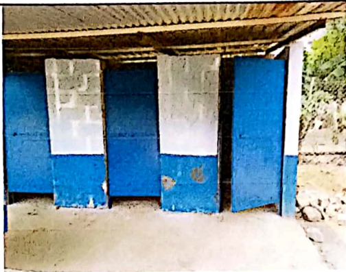
Renglon No. 3: Foto del proyecto del cambio de las puertas del servicio sanitario, finalizado.
