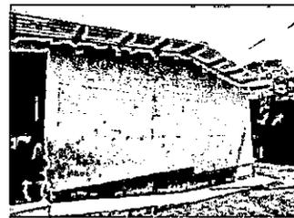
FOTO 6 REPARACION DE REPELLO Y CERNIDO DE PAREDES RENGLÓN 21
