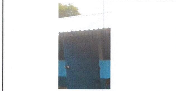
Foto 8: Sustrucción de puerta
