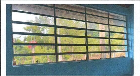
Foto 9: Sustrucción de estructura de metal de ventana
