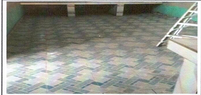
Foto 4: Sustitución de piso cerámico
