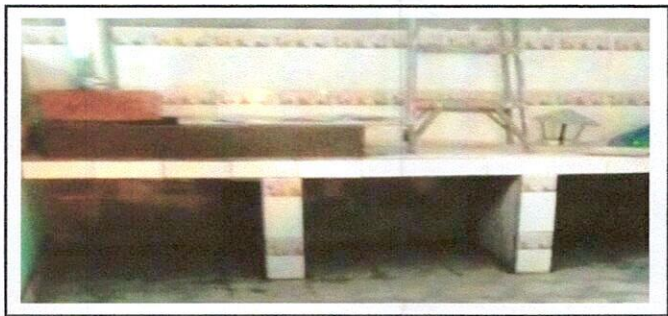
Foto 6: Instalación de azulejo en estufa rural
