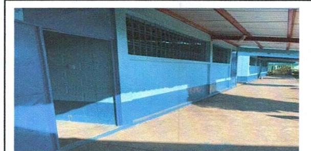
Foto 10: Pintura en muros exteriores e interiores
