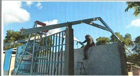
Foto 1: Sustitución de lamina, por lamina troquelada aluzinc calibre 26 modulo de aulas
