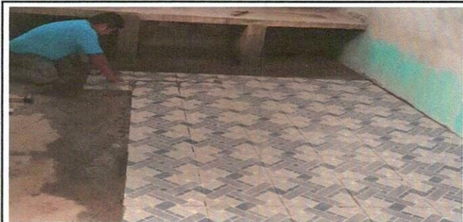
Foto 4: Sustitución de piso cerámico
