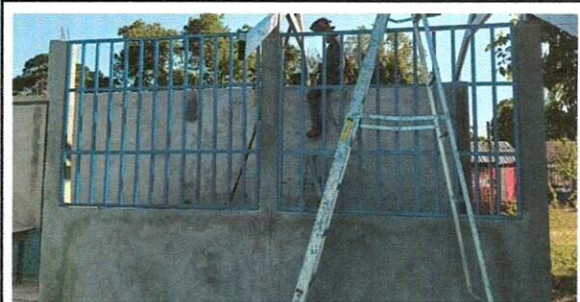
Foto 5: Sustitución de ventanas de madera por metal mas vidrio
