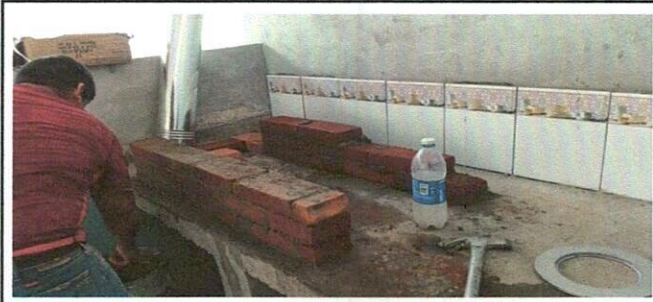
Foto 6: Instalación de azulejo en estufa rural
