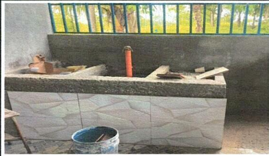
Foto 7: Sustitución de pila de cemento de dos lavadero
