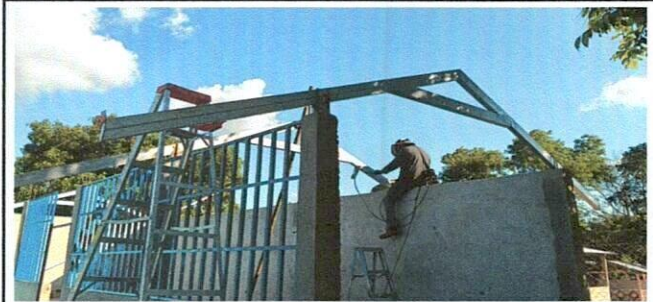
Foto 2: Sustitución de estructura de soporte de metal, por metal
