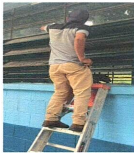
Foto 9: Sustitución de Vidrios
