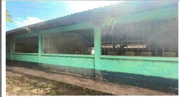
Foto 3: Mantenimiento a balcones de metal
