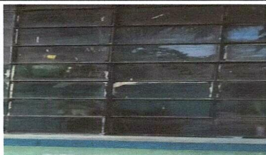
Foto 9: Sustrución de estructura de metal de ventana
