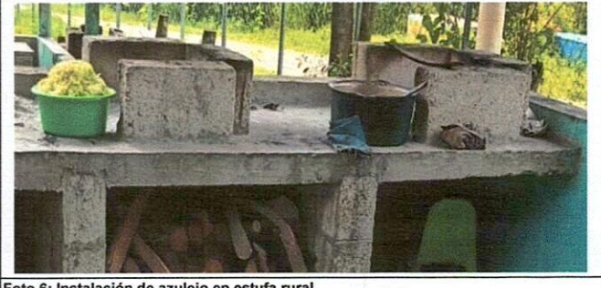
Foto 6: Instalación de azulejo en estufa rural
