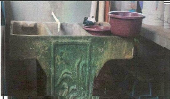
Foto 7: Sustrución de pila de cemento de dos lavadero
