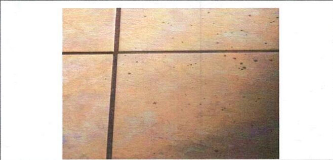
Foto 4: Sustitución de piso cerámico
