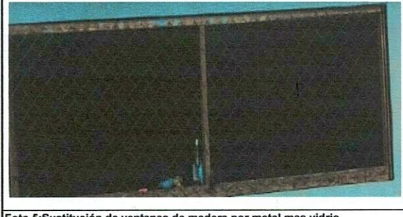
Foto 5: Sustitución de ventanas de madera por metal mas vidrio
