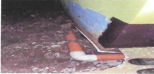
SUSTITUCIÓN DE TUBERÍA PVC LINEA PRINCIPAL AGUAS NEGRAS
