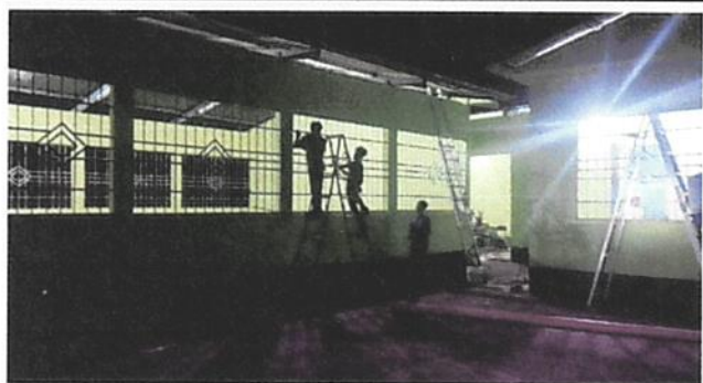
MANTENIMIENTO A ESTRUCTURA, LIJADO, SEPILLADO Y APLICACIÓN DE PINTURA
