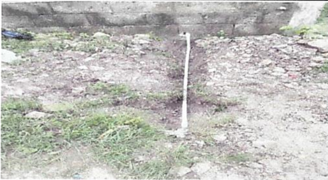
SUSTITUCIÓN DE TUBERÍA LINEA PRINCIPAL
