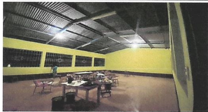
SUSTITUCIÓN DE DUCTO ELECTRICO MAS ACCESORIOS
