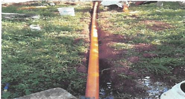
SUSTITUCIÓN DE TUBERÍA PVC LINEA PRINCIPAL AGUAS NEGRAS
