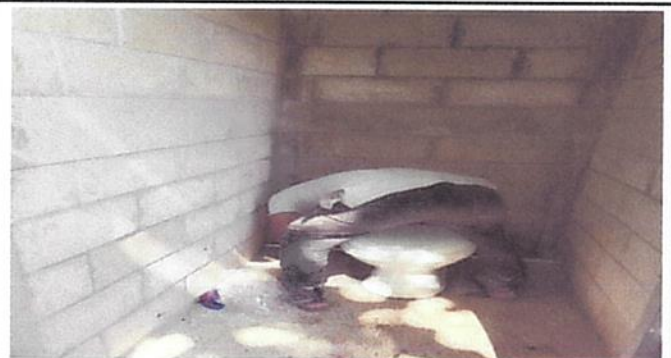
SUSTITUCIÓN DE INODORO
