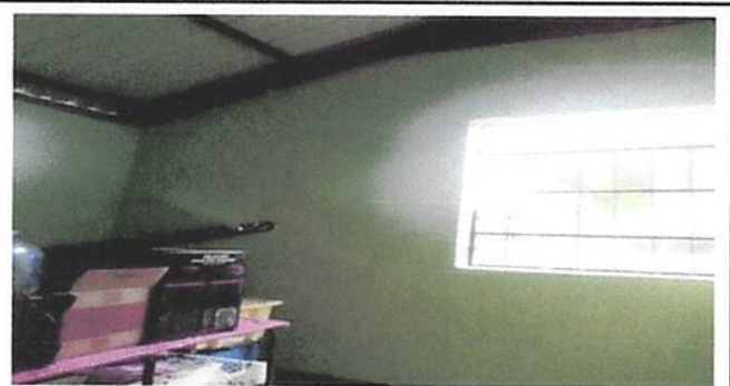
PINTURA EN MUROS EXTERIOR E INTERIOR
