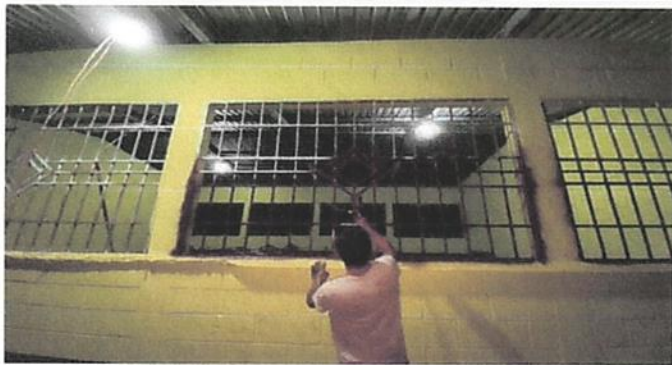
MANTENIMIENTO DE BALCON DE METAL
