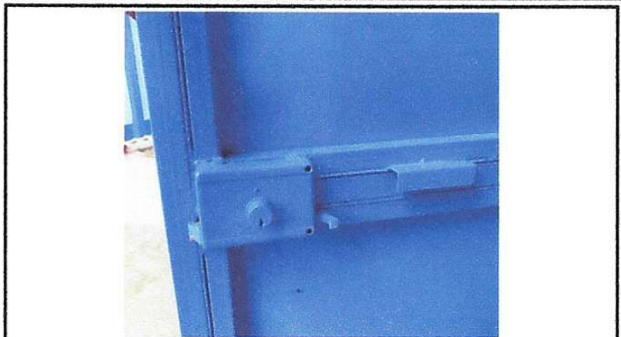
Foto 2: Sustitución de chapa
