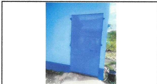
Foto 3: Sustitución de puerta
