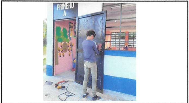
Foto 2: Sustitución de chapa
