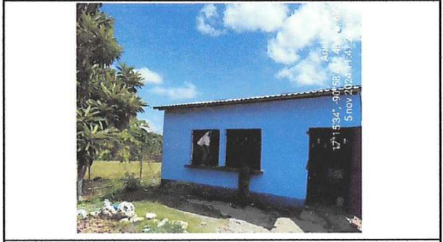
Foto 4: Sustitución de estructura de metal de ventana
