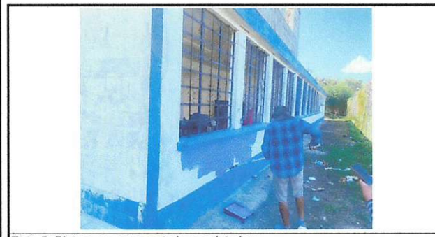
Foto 5: Pintura en muros exteriores e interiores
