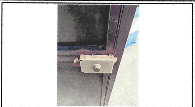
Foto 2: Sustitución de chapa
