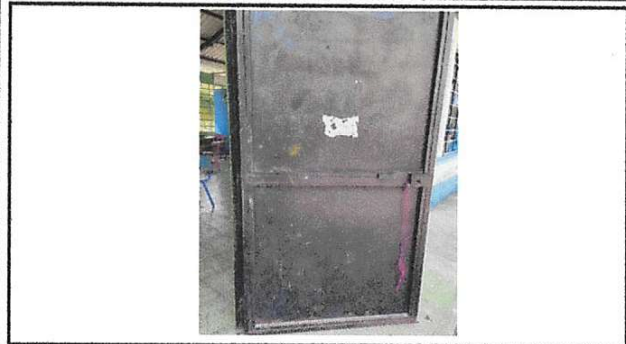
Foto 1: Mantenimiento a estructura (lijado, cambio de tubo, cepillado, sujecciones, aplicación de pintura)
