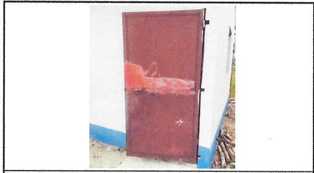
Foto 3: Sustitución de puerta
