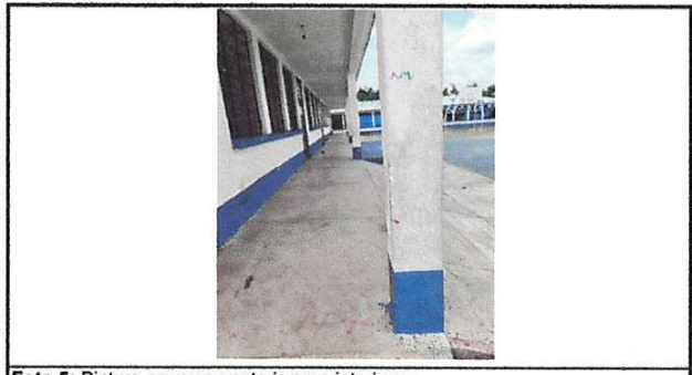
Foto 5: Pintura en muros exteriores e interiores
