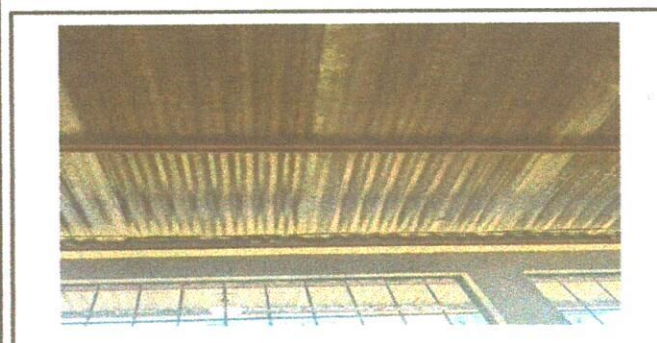
Foto 5: desinstalación de láminas existentes
