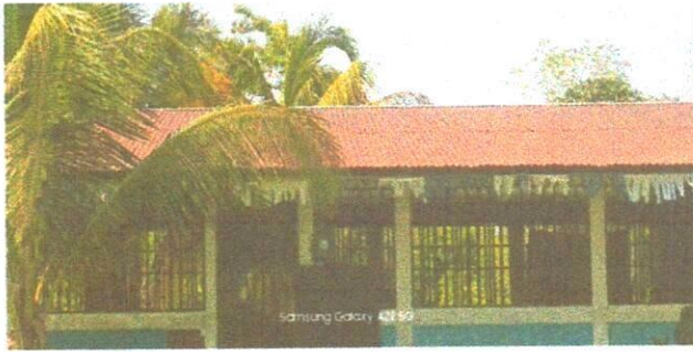
Foto 3: Sustrucción de elementos de fijación
