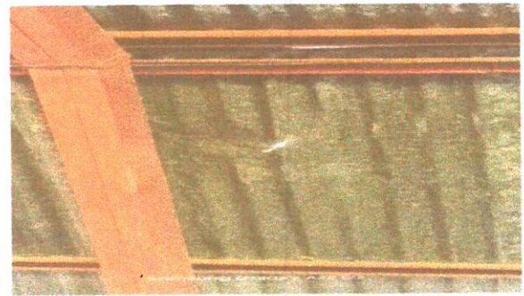
Foto 4: Mantenimiento a estructura de soporte de metal
