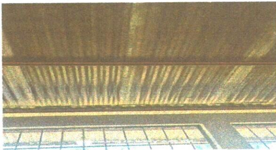
Foto 5: desinstalación de láminas exitentes
