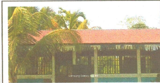
Foto 3: Sustrucción de elementos de fijación
