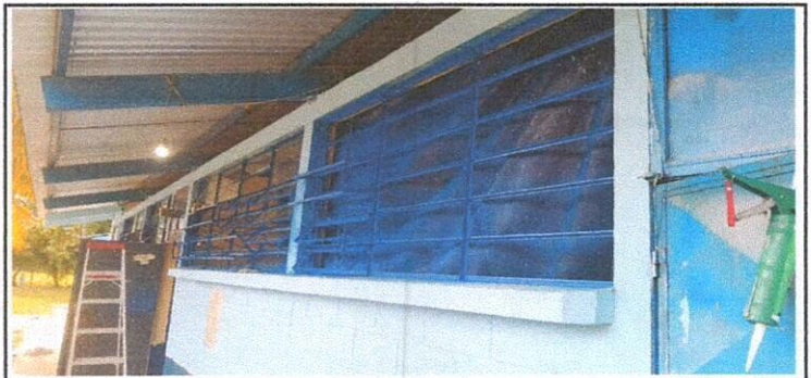
Foto 6: Sustitucion de vidrios
