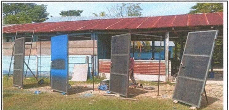
Foto 4: sustitucion de puertas
