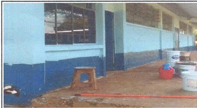
Foto 3: Pintura en muros exteriores e interiores
