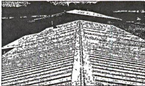
Foto 1: Sustrucción de lamina, por lamina troquelada aluzinc calibre 28 modulo de aulas
