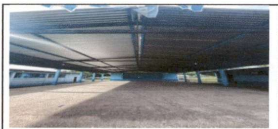
Foto 6: Desinstalación de lámina existente
