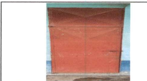
Foto 3: Mantenimiento a estructura (lijado, cambio de tubo, cepillado, sujeciones, aplicación de pintura) a puerta de aulas
