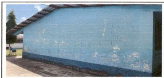
Foto 4: Pintura en muros exteriores e interiores
