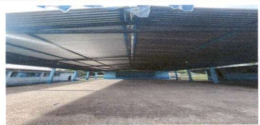
Foto 8:Instalación de lámina troquelada aluzinc
