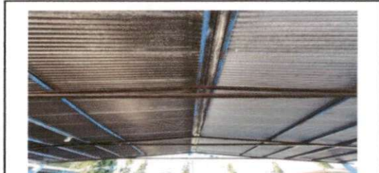
Foto 2: Sustrucción de estructura de soporte de metal, por metal
