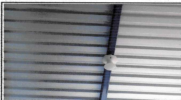
Foto 10: Sustitución de plafoneras
