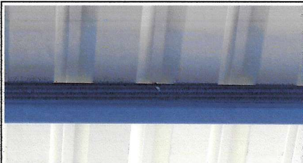
Foto 3: Sustitución de elementos de fijación.
