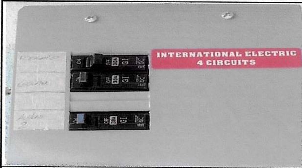
Foto 13: Sustrucción de flipones
