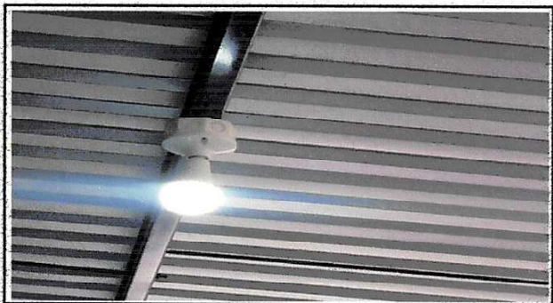
Foto 9: Sustitución de focos ahorradores
