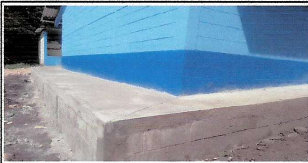
Foto 5: Reparación de banquetas de concreto
