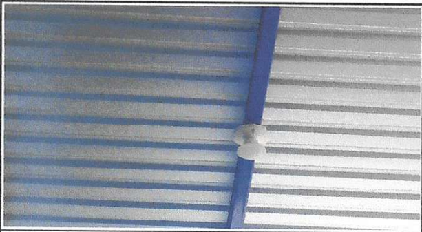
Foto 9: Sustitución de focos ahorradores
