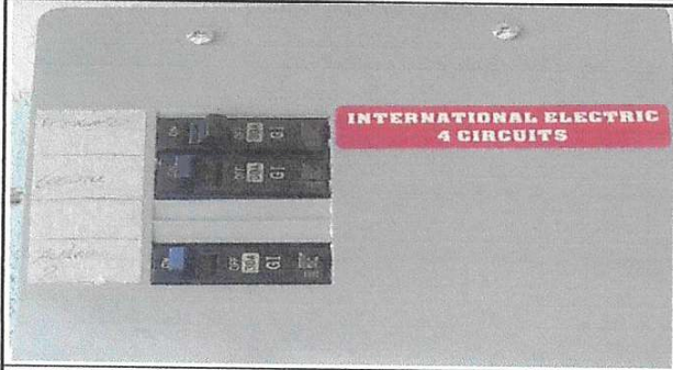
Foto 13: Sustrución de flipones
