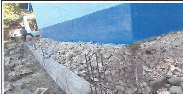
Foto 5: Reparación de banquetas de concreto
