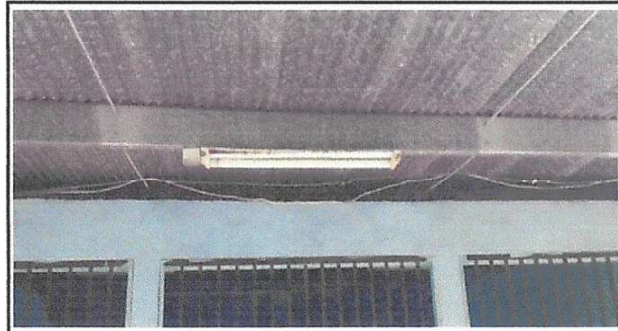
Foto 10: Sustrucción de plafoneras
