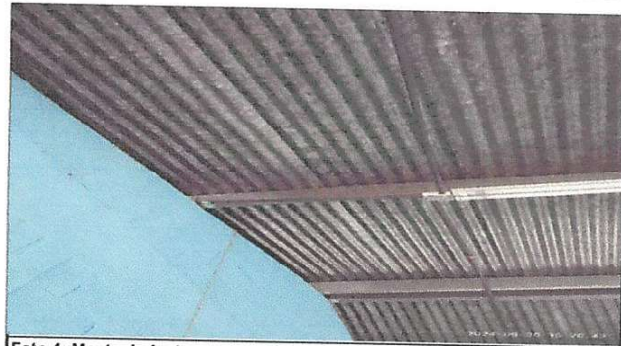
Foto 4: Mantenimiento a estructura de soporte de metal
