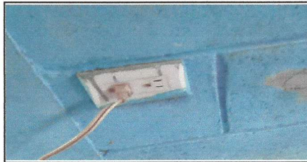
Foto 12: Sustrucción de tomacorrientes dobles
