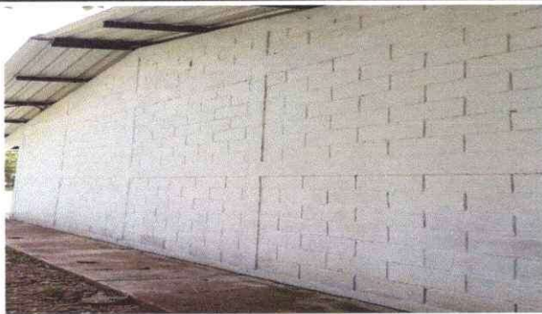
Foto 3 Pintura en muros exteriores e interiores
