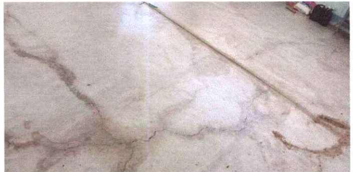
Foto 4: Sustitución de piso de torta de concreto
