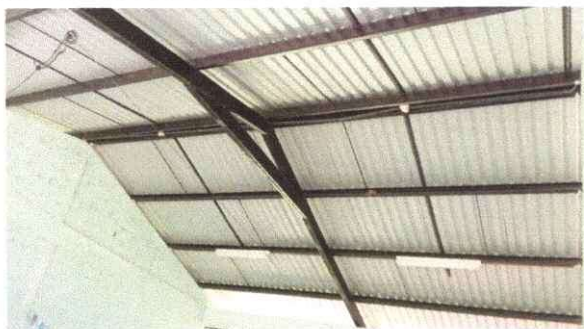
Foto 5: Sustitución de focos ahorradores
