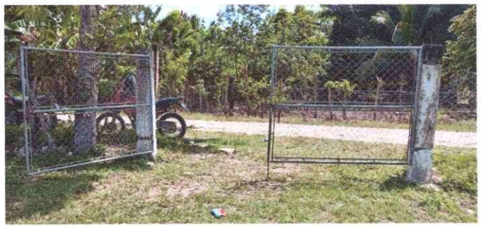
Foto 6: Sustitución de porton de metal
