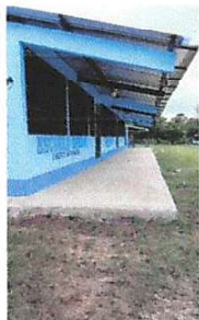
Foto 9: Reparación de piso de torta de concreto
