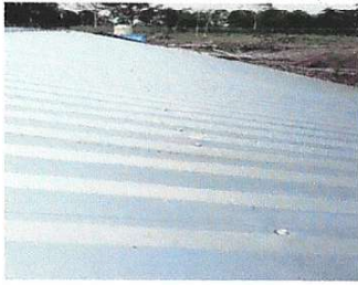
Foto 3: Sustrucción de elementos de fijación
