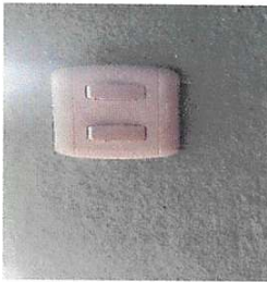
Foto 13: Sustitución de interruptores dobles
