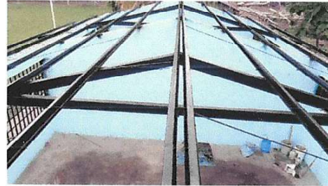
Foto 4: Mantenimiento a estructura de soporte de metal
