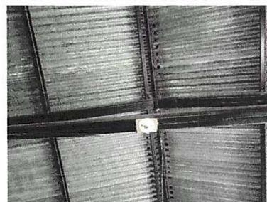
Foto 12: Sustitución de plafoneras
