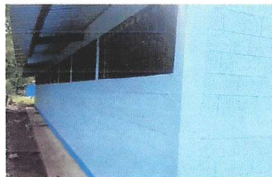
Foto 10: Pintura en muros exteriores e interiores
