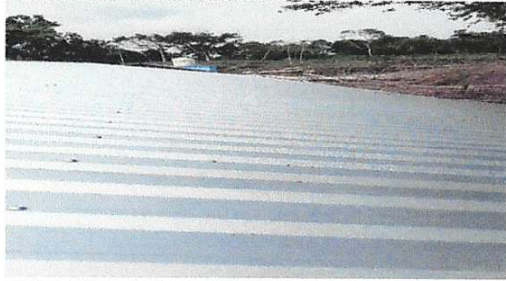
Foto 1: Sustrucción de lámina por lámina troquelada aluzinc
