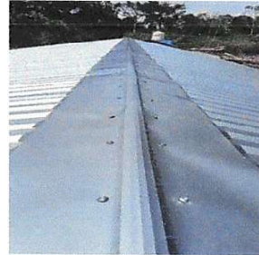
Foto 2: Sustrucción de capote de lámina, para lámina troquelada
