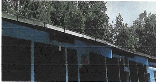
Foto 19: Sustitución de canales de metal
