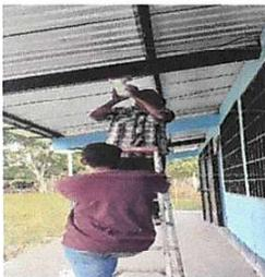
Foto 11: Sustitución de lámparas tipo Led
