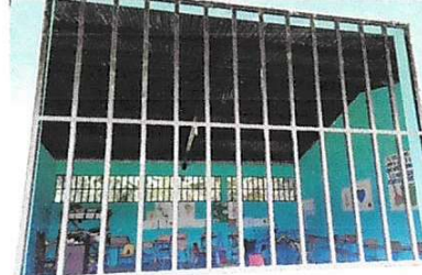
Foto 8: Mantenimiento de balcones de metal
