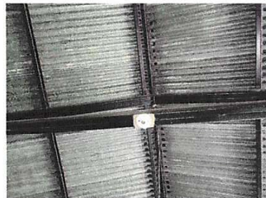
Foto 12: Sustrucción de plafoneras
