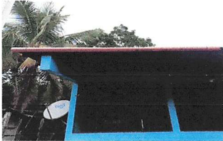
Foto 19: Sustrucción de canales de metal
