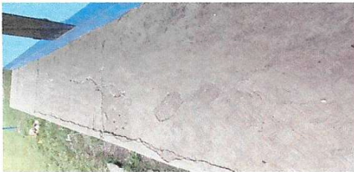
Foto 9: Reparación de piso de torta de concreto
