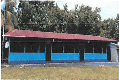
Foto1: Sustitución de lámina por lámina troquelada aluzinc
