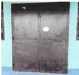
Foto 5: Mantenimiento a estructura de metal
