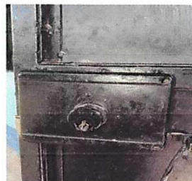
Foto 6: Sustitución de chapas
