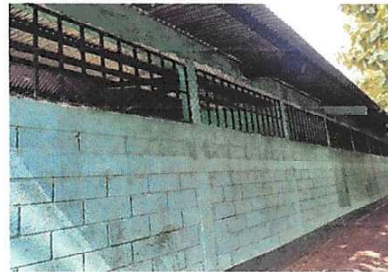
Foto 10: Pintura en muros exteriores e interiores
