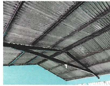
Foto 4: Mantenimiento a estructura de soporte de metal
