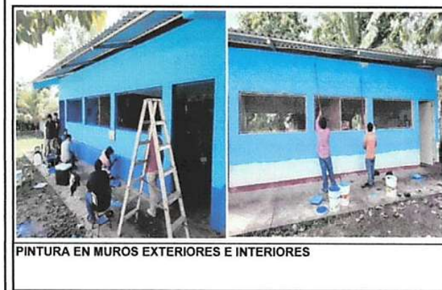
MANTENIMIENTO A ESTRUCTURA (LIJADO Y APLICACIÓN DE PINTURA)
