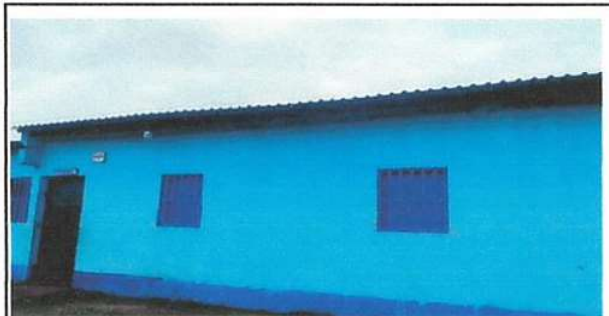
Foto 4: SUSTITUCION DE VENTANAS DE MADERA POR METAL MAS VIDRIO
