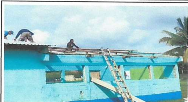
Foto 2: SUSTITUCIÓN DE CAPOTE DE LÁMINA PARA LÁMINA TROQUELADA
