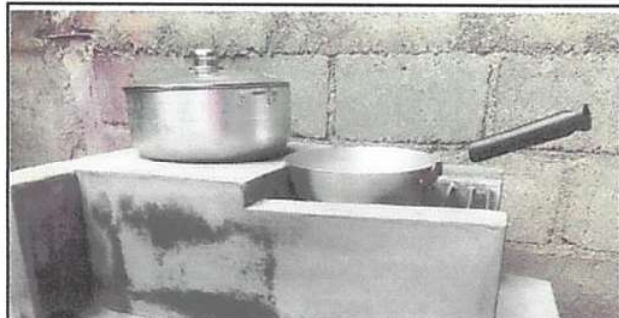
Foto 4: Instalación de azulejos en estufa rural
