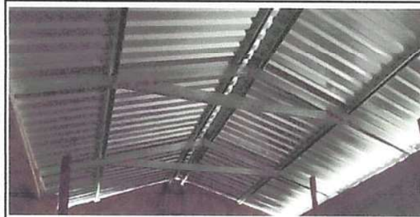
Foto 3: Sustitución de Estructura de Soporte de Madera por Metal
