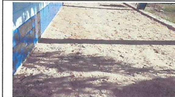
Foto 5: Reparación de piso de cemento líquido
