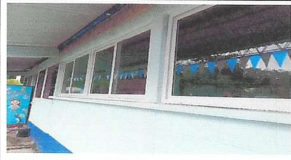
Foto 2: Sustitución de estructura de Metal de ventana
