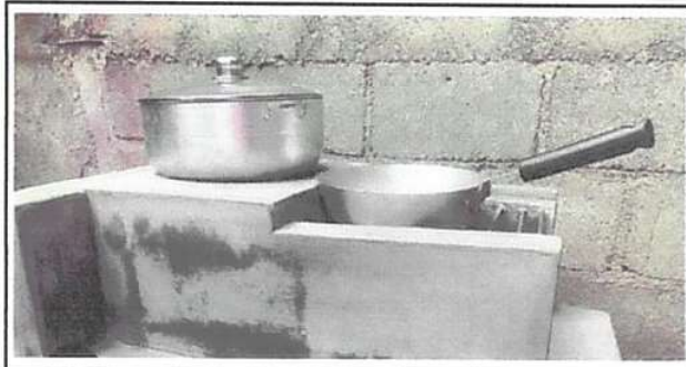
Foto 4: Instalación de azulejos en estufa rural
