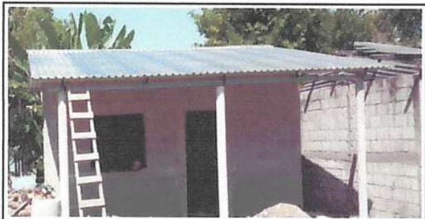
Foto 6: Sustitución de lamina, por lámina troquelada aluzinc calibre 26
