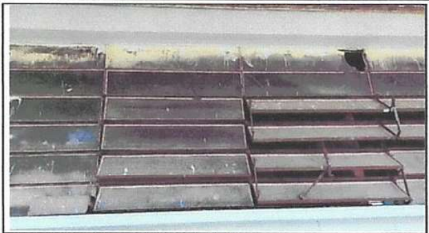
Foto 2: Sustitución de estructura de Metal de ventana
