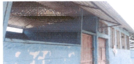
Foto 4: Sustitución de elementos de fijación
