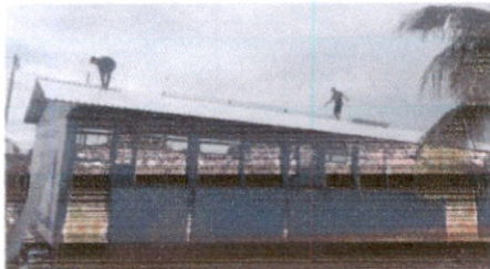
Foto 1: Sustitución de lámina, por lámina troquelada aluzinc calibre 28 modulo de aulas y dirección
