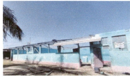
Foto 4: Sustitución de elementos de fijacion
