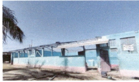
Foto 4: Sustrucción de elementos de fijacion
