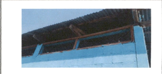
Foto 4: Sustitución de elementos de fijacion
