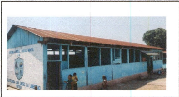
Foto1: Sustitución de lamina, por lamina troquelada aluzinc calibre 26 modulo de aulas y direccion
