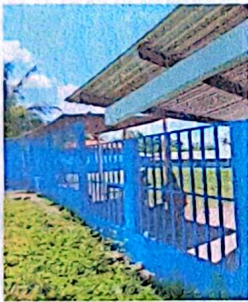
Luego de la finalización del cambio de muralla en el predio escolar.
