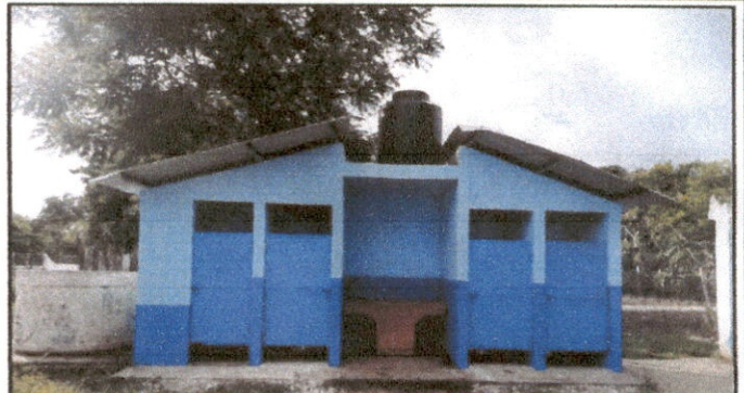
Foto 2: Se aplico pintura en los baños, se arreglo las instalaciones de tinaco con su respectiva tubería.
