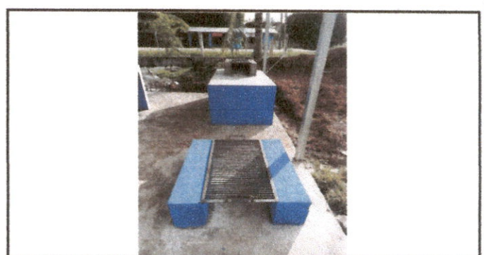
Foto 6: construccion de polleton con sus respectivas parrillas.
