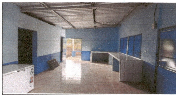
Foto 5: se realizo instalacion de energia electrica dentro de la cocina.
