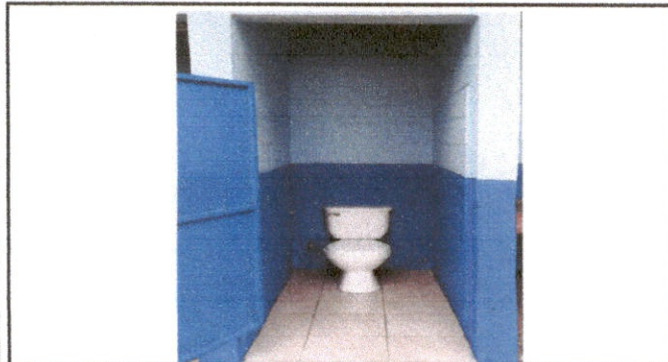
Foto 3: Sustitucion de Tazas lavables, colocacion de ceramica en los baños.
