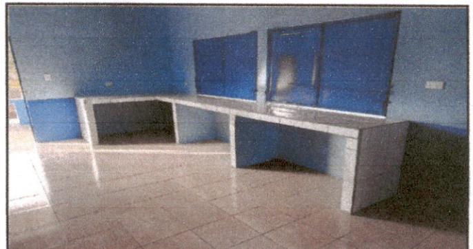
Foto 4: construccion de gabinete con su respectivo azulejo, instalacion de ceramica en la cocina, pintura en la parte interior de la cocina.
