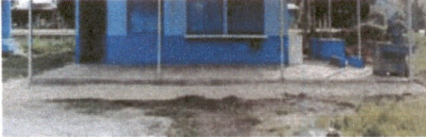
Foto 7: se realizo la preparación del piso de concreto en el area externa de la cocina.
