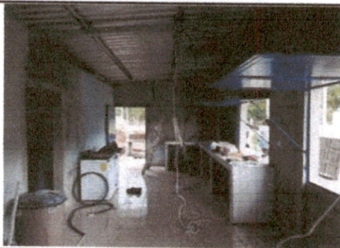
Foto 5: se esta realizando la instalación de energia electrica dentro de la cocina.
