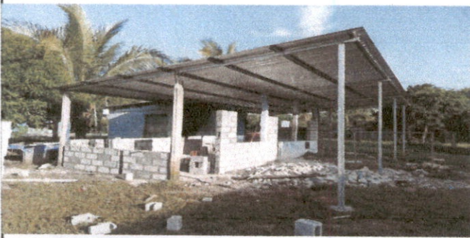
Foto1: Se esta levantado pared, se realizo cambio de lamina
