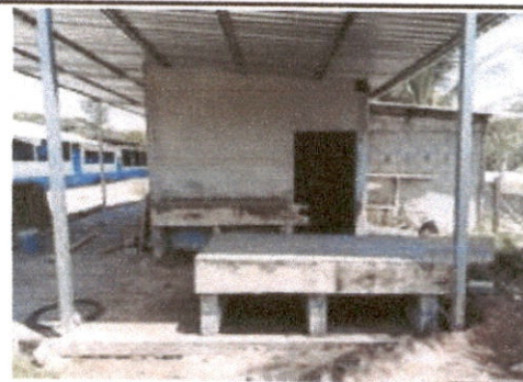
Foto 6: se esta construyendo polleton y gabinete con sus respectivas parrillas.
