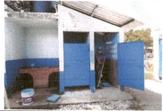
Foto 2: Se esta aplicando pintura en los baños, y se esta arreglando las instalaciones del tinaco con su respectiva tuberia.
