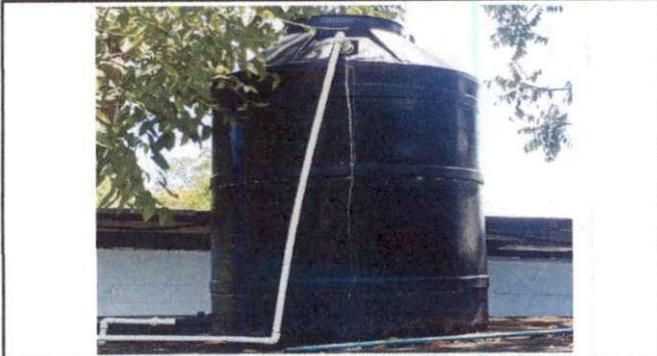
Foto13: Sustitución de deposito de agua 1700 lt
