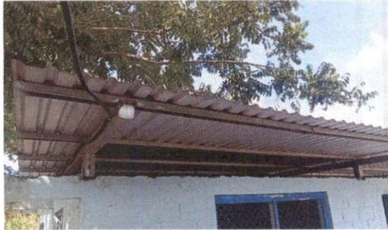
Foto1: Sustitución de lámina, por lámina troquelada calibre 26.
