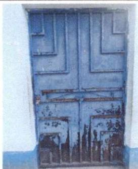
Foto 5: Mantenimiento a estructura (lijado, cepillado y aplicación de pintura de puertas)
