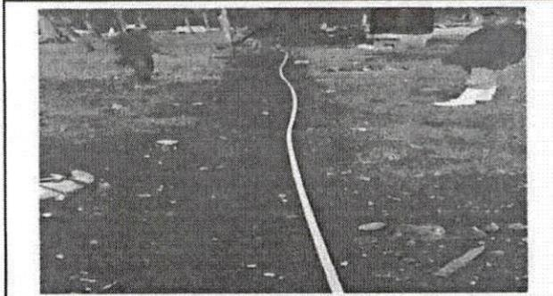
Foto 4: sustitución de tubería línea principal pvc.
