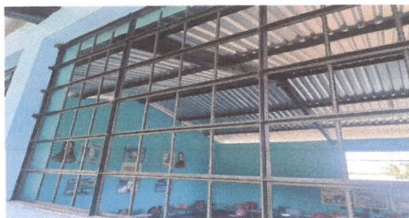
Mantenimiento a balcones de metal.
