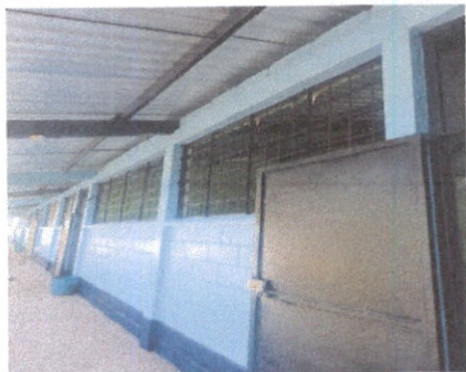
Mantenimiento a estructura de puertas de metal, sustitución de una puerta.
