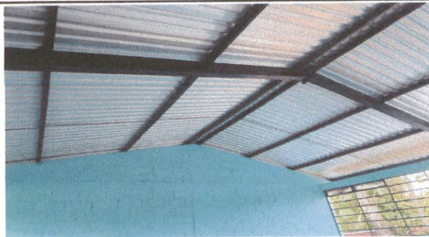
Mantenimiento de estructura de soporte de metal.
