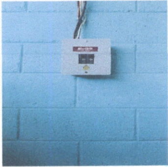
Sustitución de tablero y flipon.
