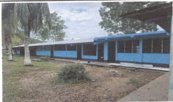
Sustitución de lámina, por lámina troquelada aluzinc calibre 26, sustitución de capote de lámina para lámina troquelada, sustitución de elementos de fijación.
