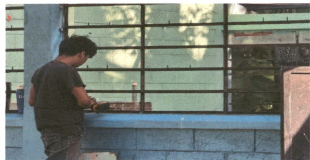
Mantenimiento a balcones de metal.
