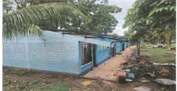
Mantenimiento de estructura de soporte de metal.
