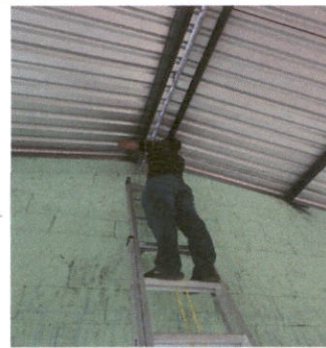
Reparación de cableado electrico de tablero y flipon.
