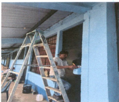
Pintura en muros exteriores e interiores.
