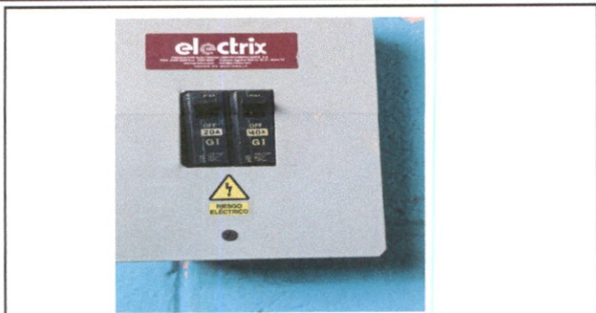
Sustitución de tablero y flipon.
