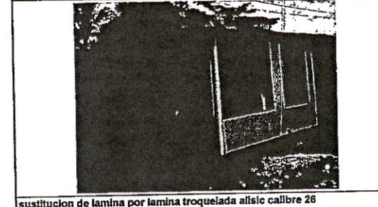
sustitucion de lamina por lamina troquelada aliso calibre 26
