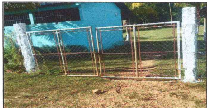
Foto 6: 15.3 Reparacion de tubo hg y malla galvanizada
