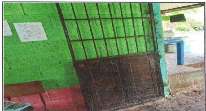
Foto 4: 4.3 sustitucion puerta de metal unidad
