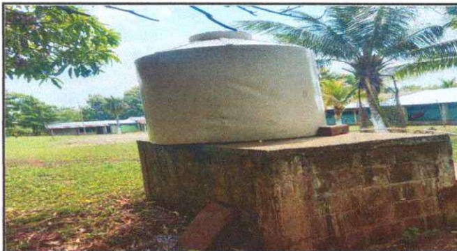
Foto 3: 18,1sustitucion de deposito de agua 1000 lt unidad
