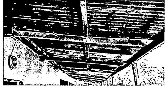
Foto 4: soporte de madera del corredor en mal estado se cambiarian por metal completamente
