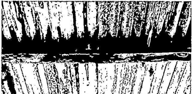
Foto 6: cargalaminas en mal estado permitiendo la filtración del agua, se cambiarian por metal completamente.
