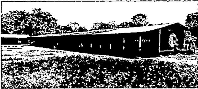
Foto 1: Techo completo en mal estado. Cuatrocientos veinte metros cuadrados, incluyendo, lámina, elementos de fijación y soporte de madera. Es lo que se trabajará.
