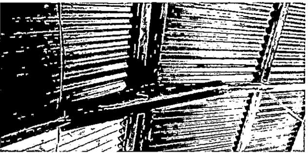
Foto 5: Tijeras de madera en mal estado por la filtración del agua
