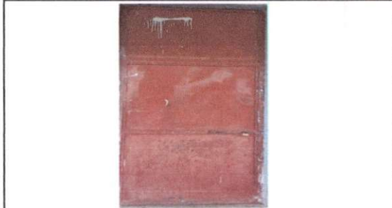
Foto 1: Sustitución de puerta
