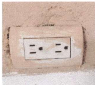
Foto 8: Sustritióón de tomacorrientes dobles
