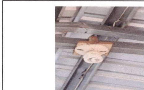
Foto 6: Sustitución de plafoneras
