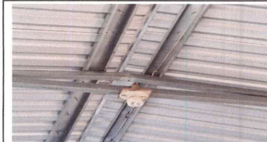
Foto 5: Sustitución de focos ahorradores
