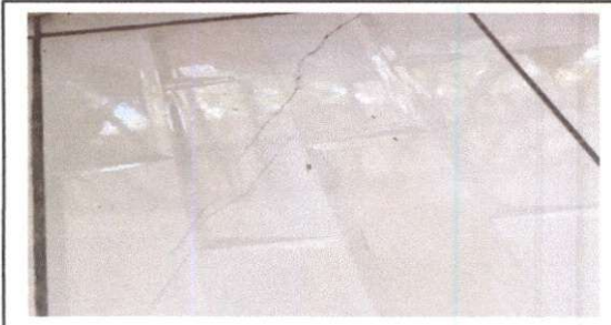
Foto 15: Instalación de azulejo en estufa rural
