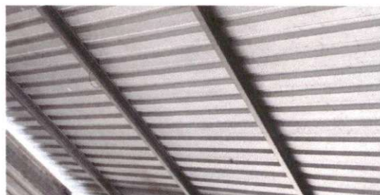
Foto 12: Sustritióón de lámina, por lámina troquelada aluzinc calibre 26
