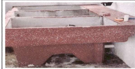
Foto 4: Sustitución de pila de cemento de un lavadero
