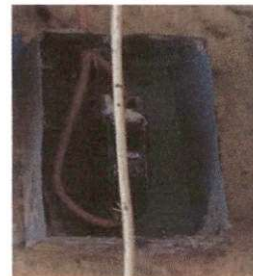
Foto 10: Sustritióón de tablero de flipones
