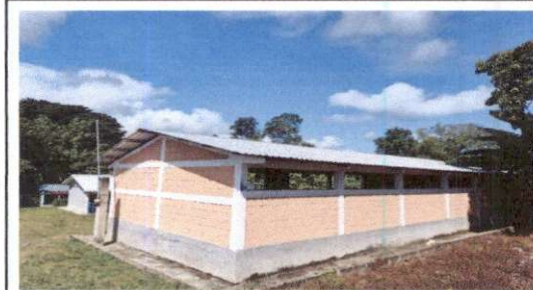
Foto 3: Pintura en muros exteriores e interiores
