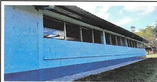
Foto 5: Sustitución de vidrios
