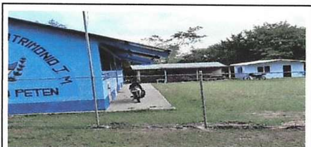
Foto 4: Pintura en muros exteriores e interiores
