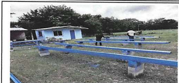
Foto 2: Mantenimiento a estructura de soporte de metal
