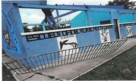
Foto 7: Mantenimiento a balcones de metal
