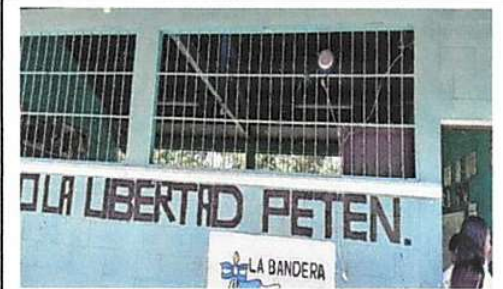
Foto 7: Mantenimiento a balcones de metal
