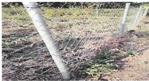
Foto 3: Reparación de tubo hg y malla galvanizada
