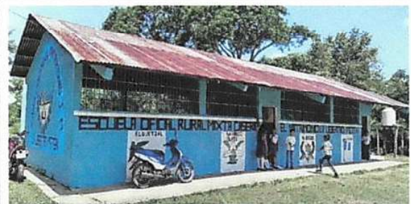
Foto 4: Pintura en muros exteriores e interiores
