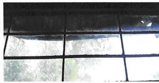
Foto 5: Sustitución de vidrios
