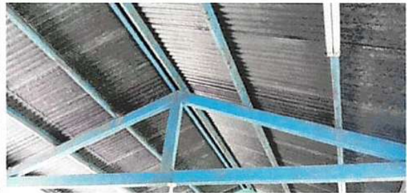
Foto 2: Mantenimiento a estructura de soporte de metal
