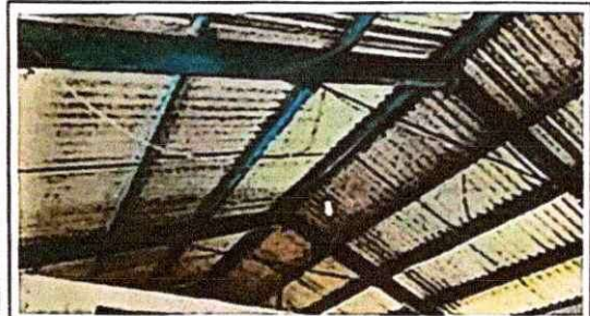
Foto 9: reparación de cableado eléctrico
