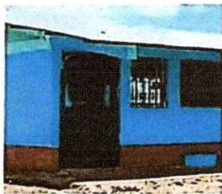
Foto 5: Sustitución de puerta
