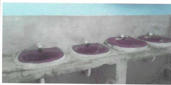
Foto 11: SUSTITUCIÓN DE LAVAMANOS
