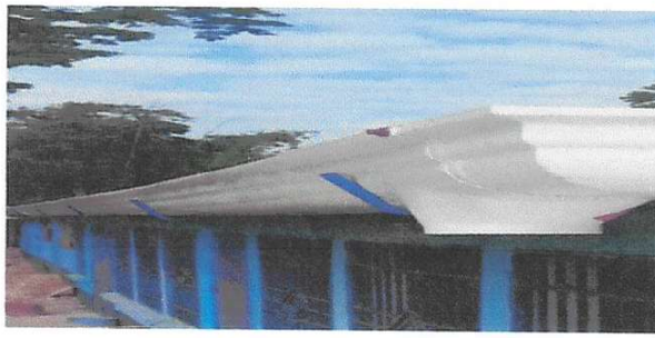
Foto 9: SUSTITUCIÓN DE SOPORTE O PESCANTE DE METAL PARA CANAL
