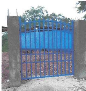
Foto 5: SUSTITUCIÓN DE PORTÓN DE METAL
