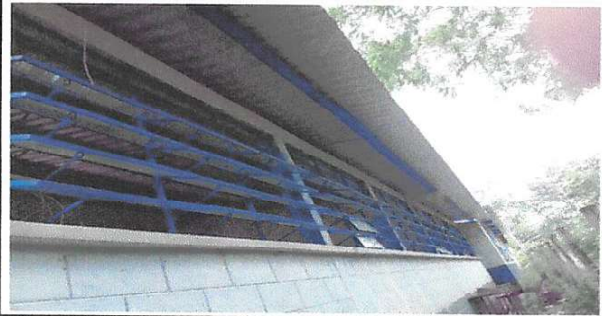
Foto 6: SUSTITUCIÓN DE VIDRIOS
