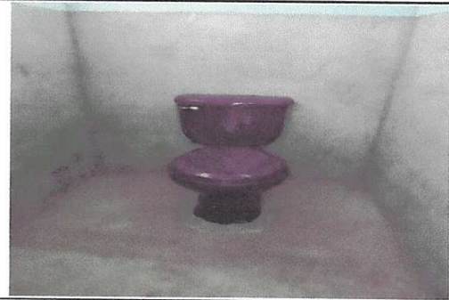
Foto 10: SUSTITUCIÓN DE INODORO
