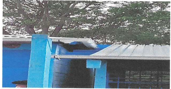
Foto 8: SUSTITUCIÓN DE CANAL PVC
