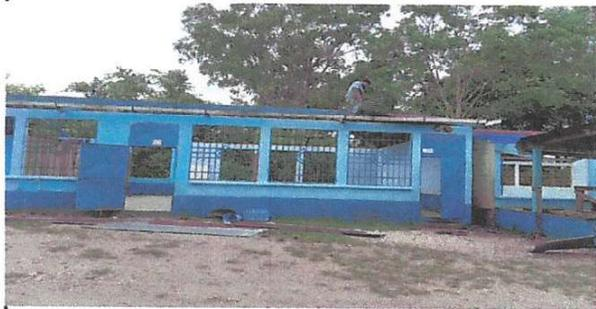
Foto1: SUSTITUCIÓN DE CAPOTE DE LÁMINA PARA LÁMINA TROQUELADA
