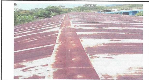
Foto1: SUSTITUCIÓN DE CAPOTE DE LAMINA PARA LÁMINA TROQUELADA
