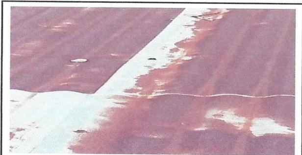
Foto 3: SUSTITUCIÓN DE ELEMENTOS DE FIJACIÓN
