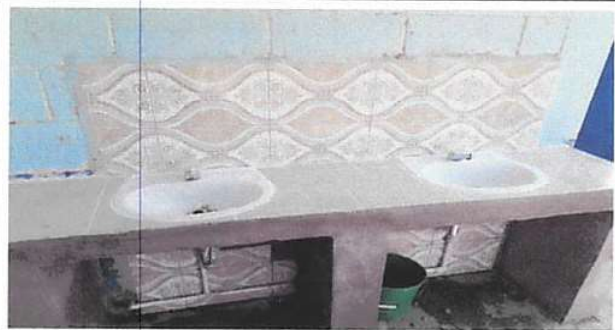
SUSTITUCIÓN DE LAVAMANOS
