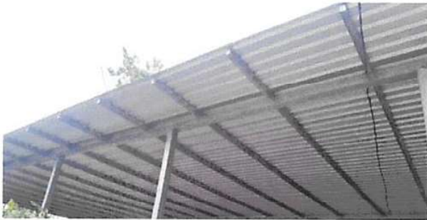
SUSTITUCIÓN DE ESTRUCTURA DE MADERA, POR METAL
