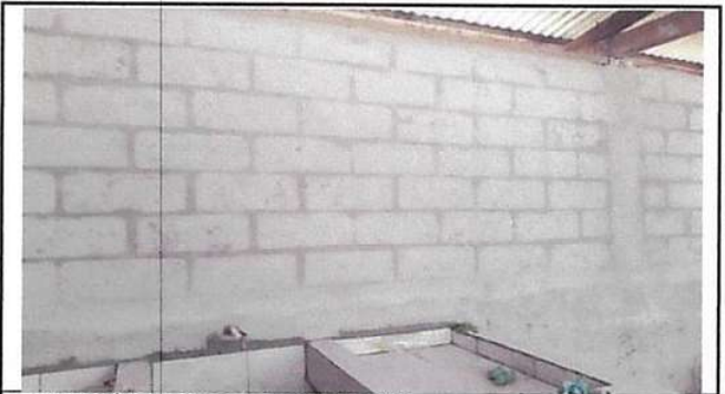
REPARACIÓN DE MURO DE CONTENCIÓN
