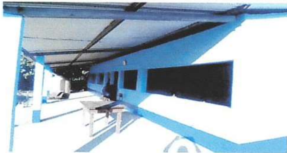
PINTURA EN MURO EXTERIOR E INTERIOR
