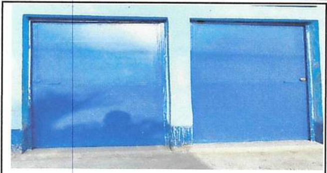
MANTENIMIENTO EN PUERTA EN SERVICIO SANITARIO
