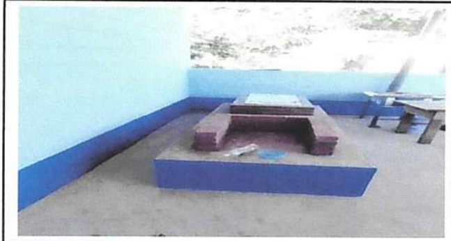
MANTENIMIENTO A ESTUFA RURAL
