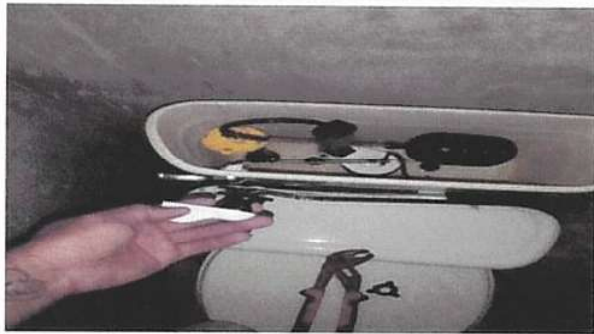
SUSTITUCIÓN DE ACCESORIOS PARA INODORO
