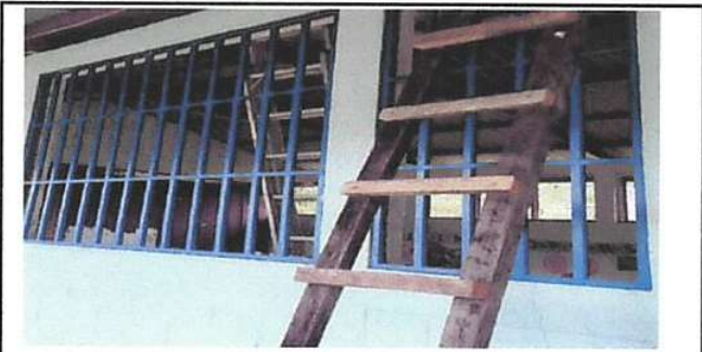
SUSTITUCIÓN DE ESTRUCTURA DE METAL DE VENTANA
