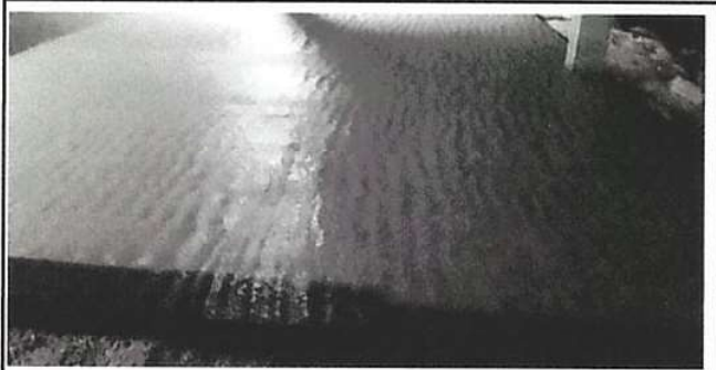
SUSTITUCIÓN DE PISO DE TORTA DE CEMENTO
