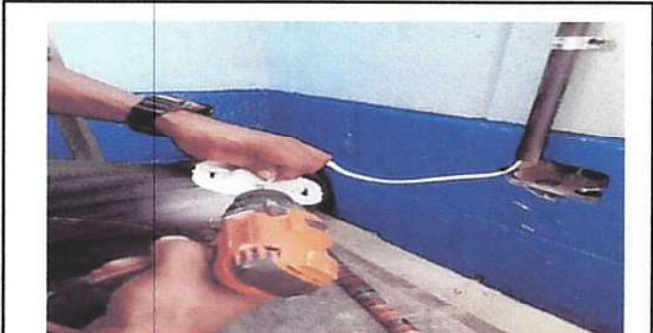
SUSTITUCIÓN DE TOMACORRIENTES DOBLES
