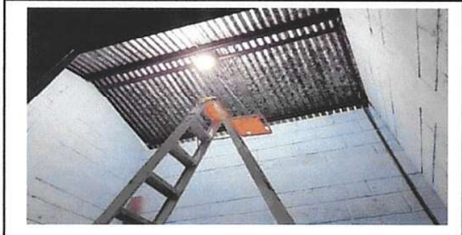
SUSTITUCIÓN DE PLAFONERAS
