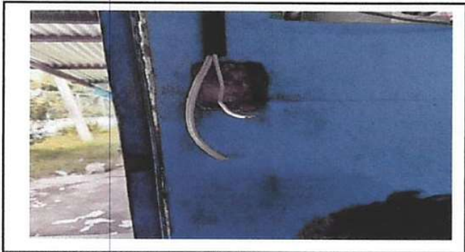
SUSTITUCIÓN DE CABLEADO PRINCIPAL
