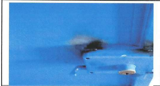
SUSTITUCIÓN DE CHAPAS
