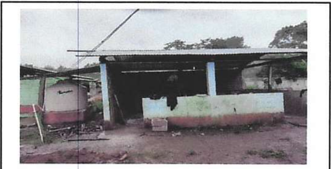
SUSTITUCIÓN DE TUBERIA LINEA PRINCIPAL
