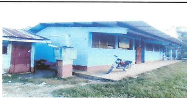
PINTURA EN MURO ESTERIOR E INTERIOR
