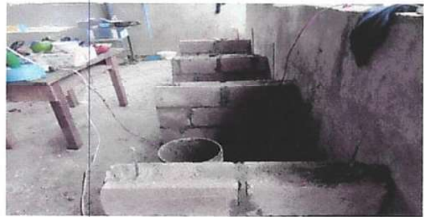
SUSTITUCIÓN DE PILA DE CEMENTO DE 2 LAVADEROS
