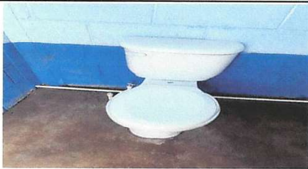
SUSTITUCIÓN DE ACCESORIOS PARA INODORO
